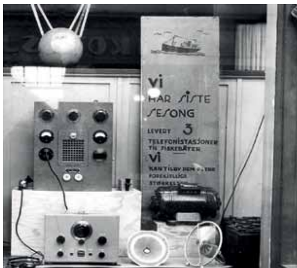
Utstilling hos Brommeland Radio i midten av 1930-årene. Sender og mottaker for radiotelefoni produsert av Elektrisk Bureau. Til høyre er også utstilt nødvendige akkumulatorbatterier og en roterende spenningsformer. Båten måtte selvsagt ha lysesagg installert.
