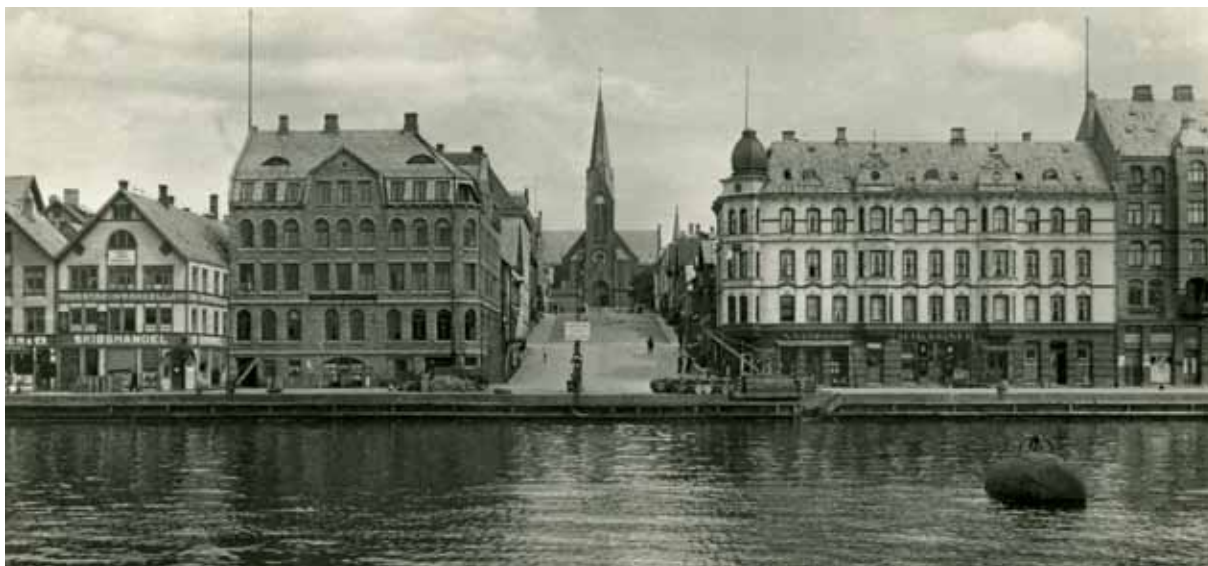
Stasjonens to antennemaster var plassert på Postgårdens og Hotell Norges tak. Bildet er fra 1919, mens installasjonen foregikk. Det er ennå ikke strukket antenne mellom mastene. Foto: MHB-F:00107
