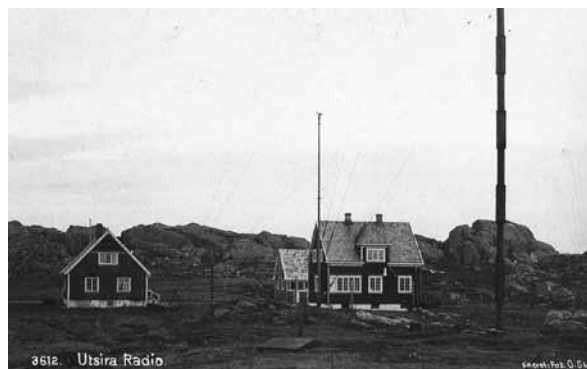
Utsira Radio 1930. Hovedbygningen med radioinstallasjonene til høyre. På baksiden en bygning som huset aggregat til strømforsyning og akkumulatorer. Huset til venstre er funksjonærbolig.
