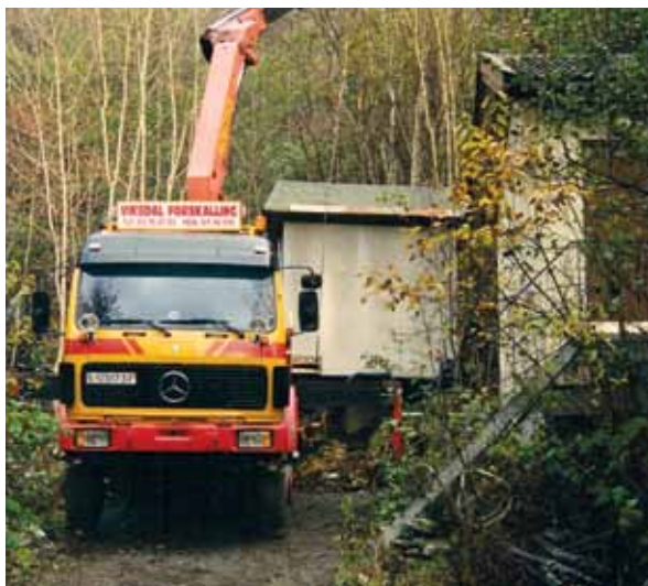
Kiosken vert henta i Ilsvåg og lyft heil over på lasteplanet. Huset med dagens sentral til høgre.
