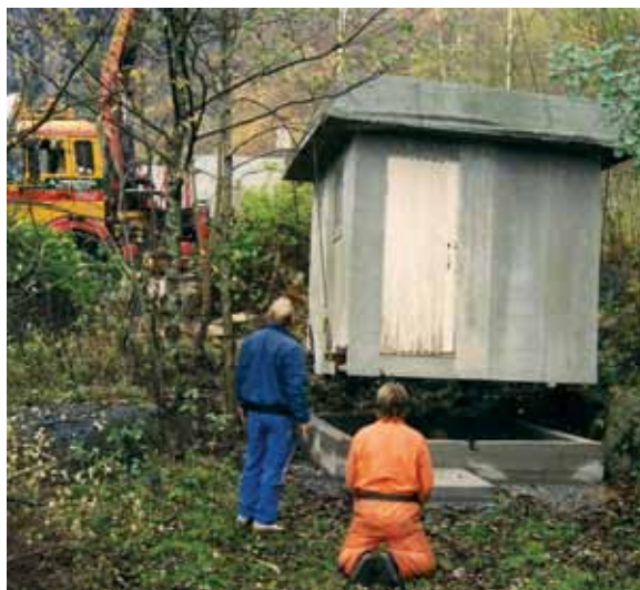
Her kjem huset på plass på ferdigstøypd grunnmur på bygdemuseet. Harald Hundseid i blått overvakar operasjonen medan Jakob Matre på kne, finmanøvrerer krana.
