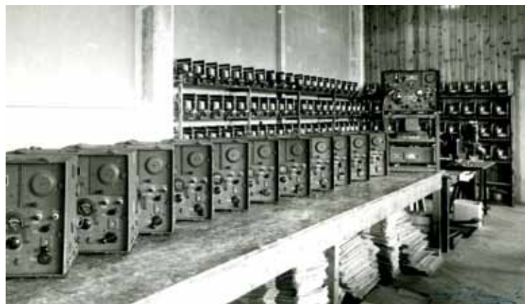
En serie av ombygde Crosley-radiotelefoner på lageret hos Norman Radio. På hyllene står ferdige "Norman" radioer klare til å monteres i kabinetter.
