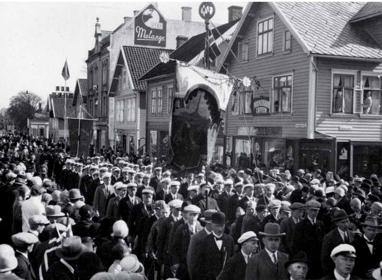
Dette bildet er tatt 17. mai 1930. Fotografen står på hjørnet Skippergata/Haraldsgata, omtrent der hvor inngangen til Den norske Bank er i dag. I flere av husene vi ser, var det kafeer. I 2. etasje nærmest var Promenadekaféen, som senere ble overtatt av Hvite Bånd. Sør for denne, i Haraldsgata 118 var Boulevard, og i 116 åpnet Bien. I lokalene holdt senere Fredheim kafé til . Foto: Knut Morlands samling
